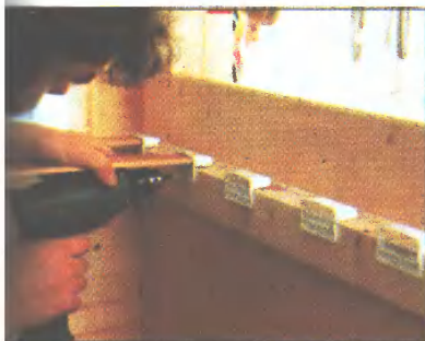
16. Гибкие планки и амортизаторы решетки (опоры матраца) закрепляют в специальных «карманах» сначала с одной стороны...
